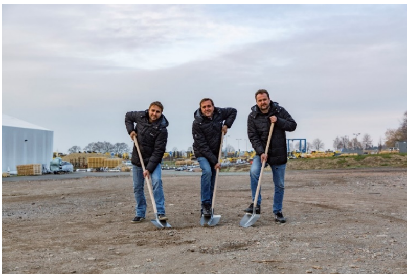
Właściciel BEDNAR FMT wraz z synami na placu budowy nowej hali produkcyjnej.
