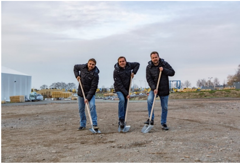
A BEDNAR FMT tulajdonosa a fiaival az új, kétszintes csarnok építési területén.
