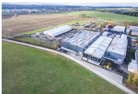
Siedziba zakładów produkcyjnych w Rychnowie nad Knežnou, Republika Czeska
